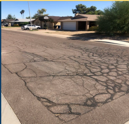
Asphalt Repave + ADA
