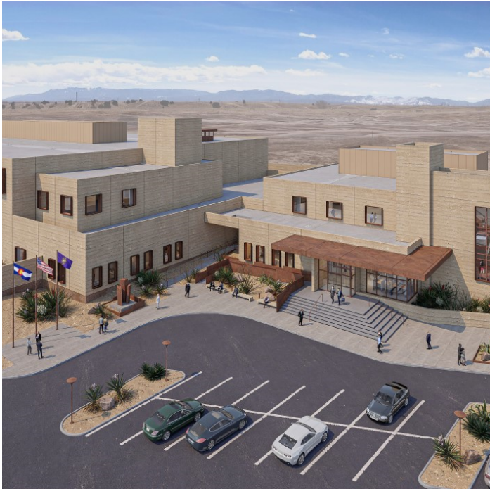
Pueblo County Detention Center, Pueblo, CO.
