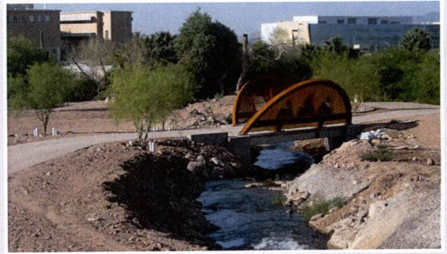
Tempe Crosscut Canal
