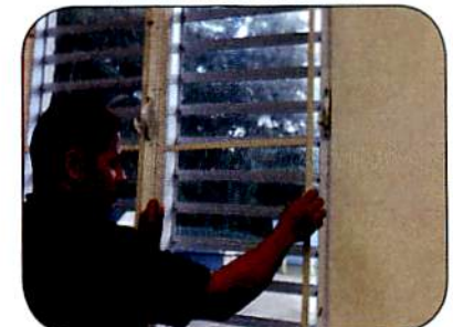
Instale o repare la malla o tela metálica de ventanas y puertas.
