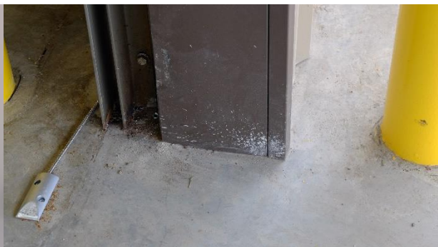
4.38 clean exterior door frames.
