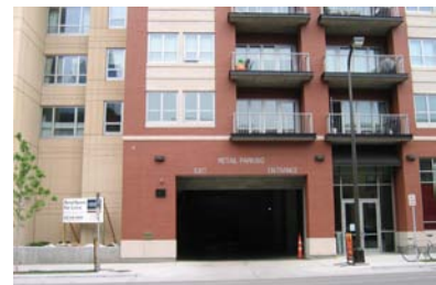
Garage door placement
