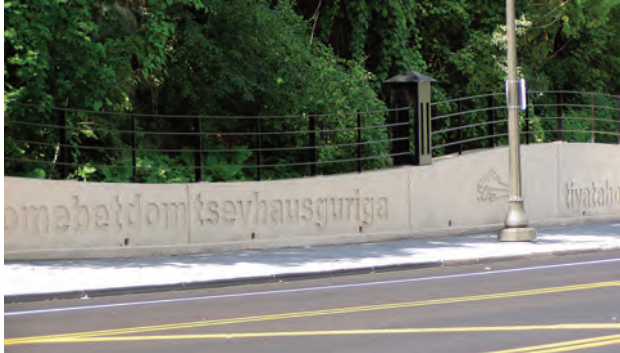
Wabasha Avenue retaining wall. Seitu Jones.
