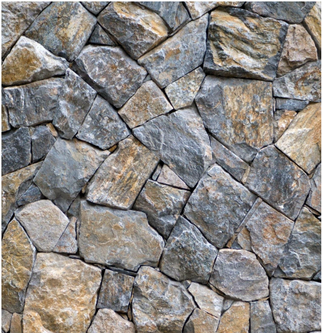
Exterior/Interior Stone Finish
